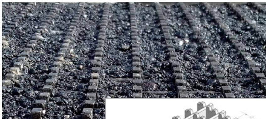
**P**er la prima volta in Italia, è stato installato a Palmanova lo "Stop Salvapedoni", il dispositivo stradale che consente di ridurre notevolmente lo spazio di frenata dei veicoli in prossimità delle strisce pedonali. È stato realizzato e brevettato dall'azienda friulana Smart Way srl, dopo un lungo periodo di ricerca che ha coinvolto anche l'Università di Padova.
